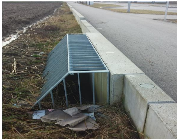
Abbildung 7: Einlaufbauwerk mit Rechen - Beispiel
